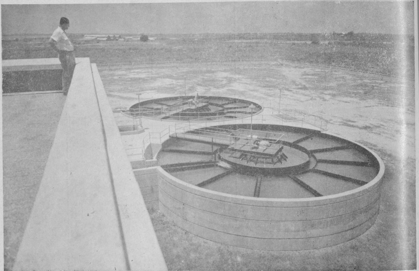
Un aspecto de las nuevas instalaciones que acaban de construirse en el Acueducto dentro del plan de ensanche de su capacidad.
