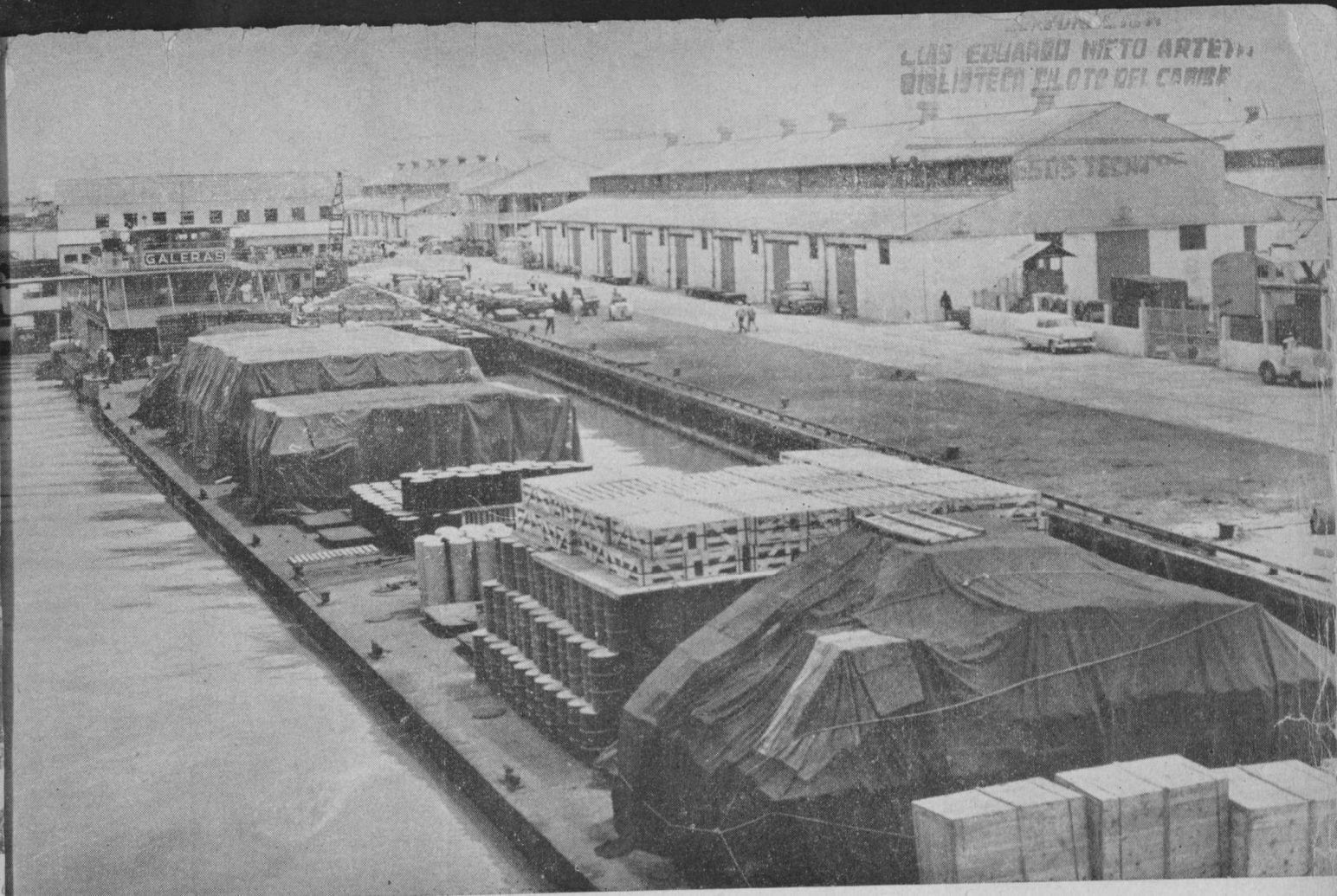
En el mismo Terminal Marítimo los planchones fluviales son cargados. Véase una de las dársenas del Terminal donde arriban los barcos fluviales. Su magnífico tablestacado es una obra admirable de la Adenavi.
