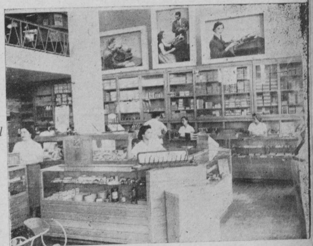
Vista parcial del interior de los Almacenes Moggollón.
