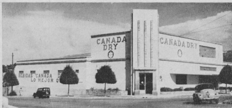
Fábrica de Gaseosas "Canada Dry".
