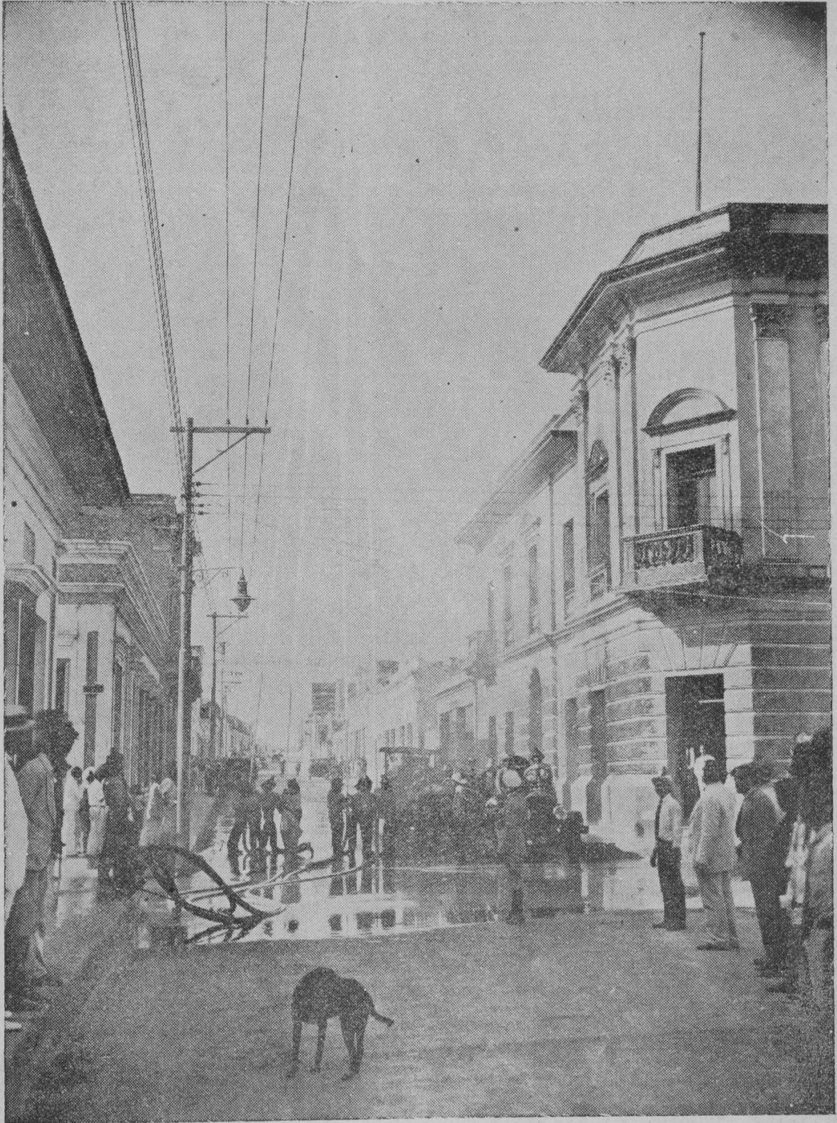
El Cuerpo de Bomberos operando como ensayo con 4 líneas de mangueras conectadas a un hidrante frente al Palacio de Gobierno
