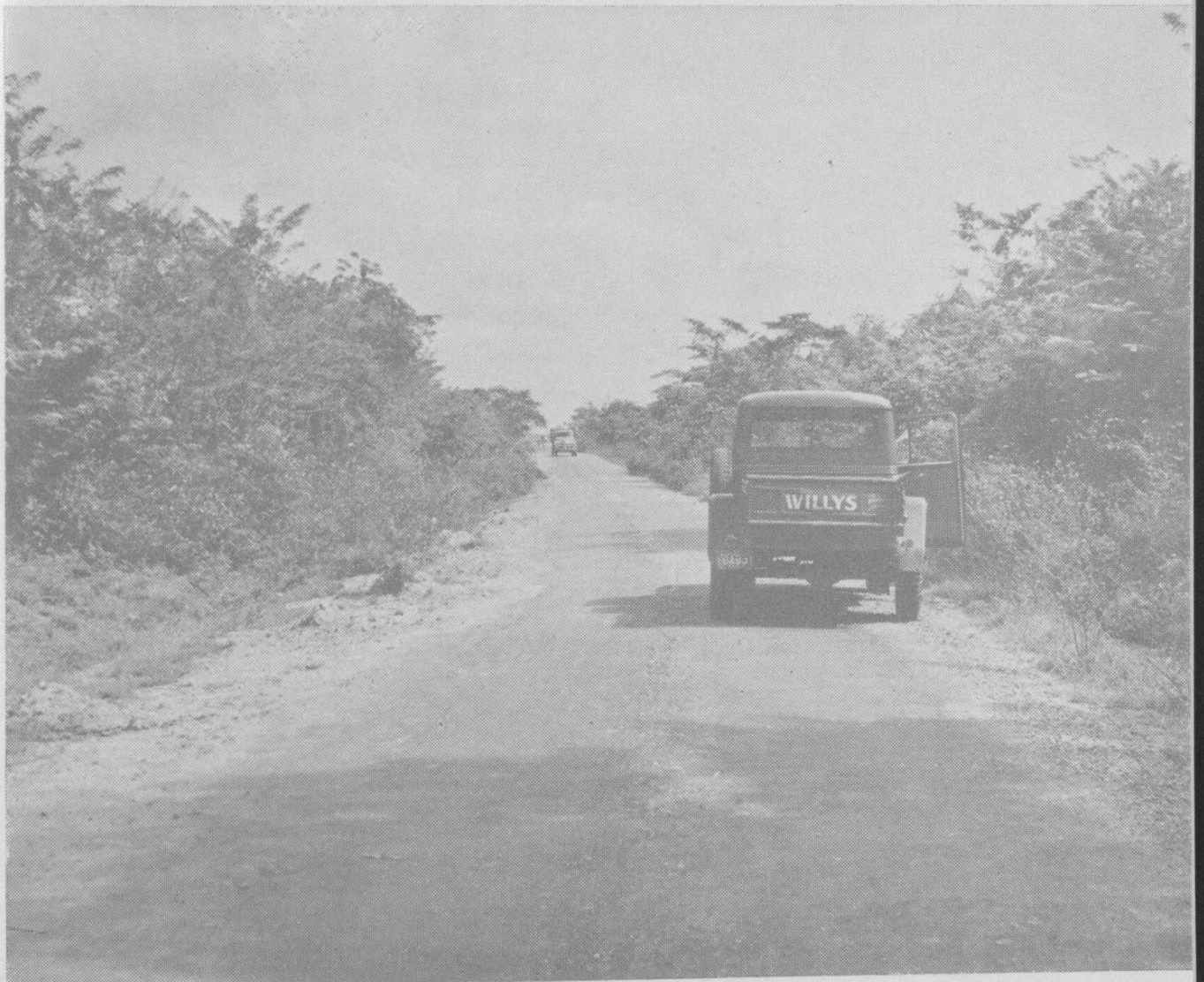
Carretera Sabanalarga-Manatí (27 kilómetros) carretera de desembotellamiento agrícola y ganadero, construída en colaboración con la Secretaría de Agricultura.
