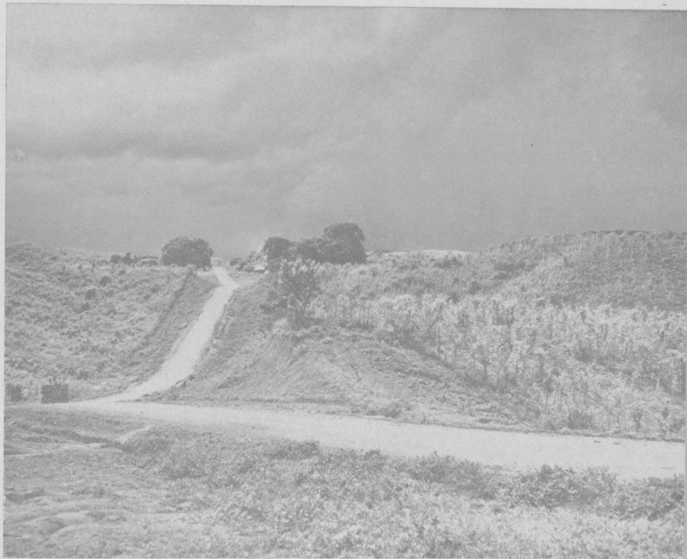
Carretera Repelón-Villa Rosa-San Etanislao con una longitud aproximada de once kilómetros, construída también por la Secretaría de Obras Públicas durante el año de 1955, la cual acorta la distancia de San Etanislao a Barranquilla, por la vía de Repelón, en 30 kilómetros.
