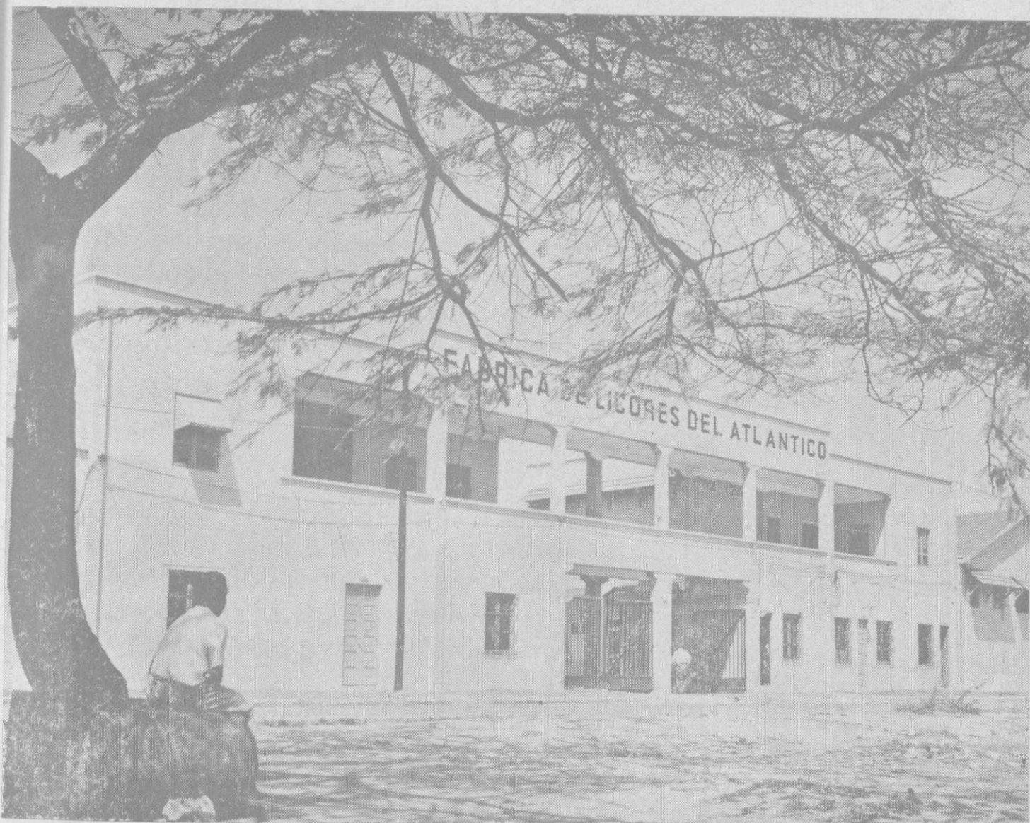
LA FABRICA DE LICORES DEL ATLANTICO.—Proyectada con miras a sus ampliaciones futuras, la Fábrica de Licores del Atlántico, situada en los terrenos de "La Loma", ha recibido el mejor impulso del gobierno del Mayor Jacinto E. Márquez, dotándola de maquinaria moderna, instalaciones amplias, dentro de una sobria construcción, que le permite ahora producir los mejores alcoholes para el uso industrial y rones añejos de primera calidad, con una producción de halagador volumen.
